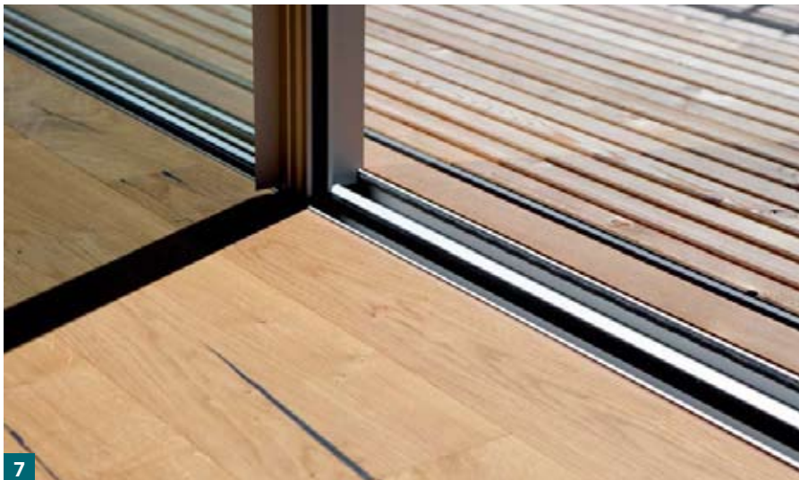
7: Das Bodenprofil der Schiebetür ist schwellenlos eingebaut. Der Übergang vom Innen- zum Aussenraum ist beinahe nahtlos.
